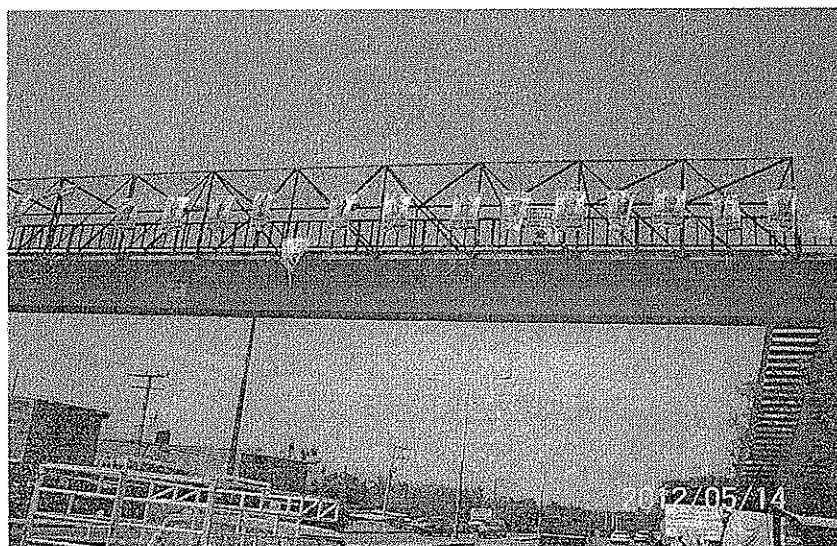
Leyenda "Puente peatonal de la carretera Xochitepec, Alpuyeca, a la altura del campo deportivo Alpuyeca".
